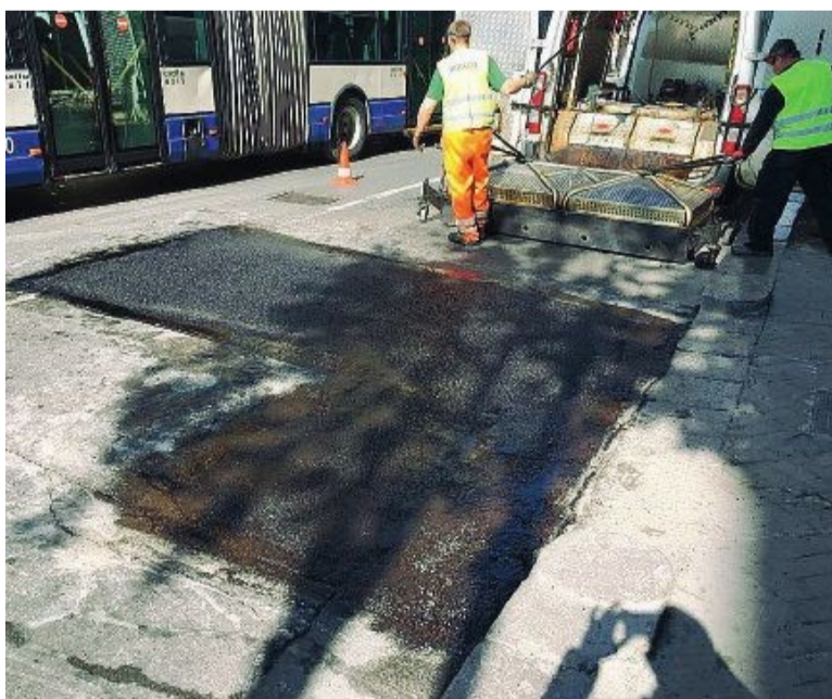
La macchina per sistemare l'asfalto utilizzata in via Roma
