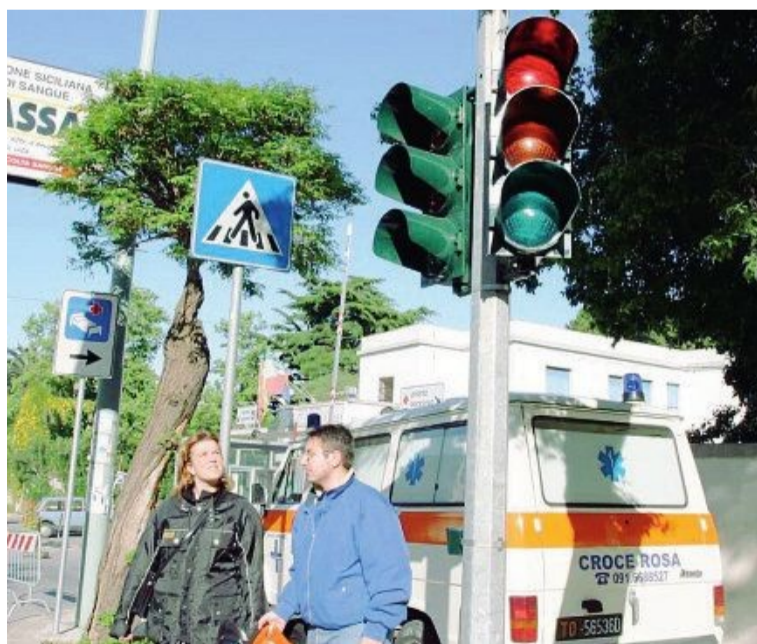
Le luci a led saranno installate nei semafori a chiamata pedonale
